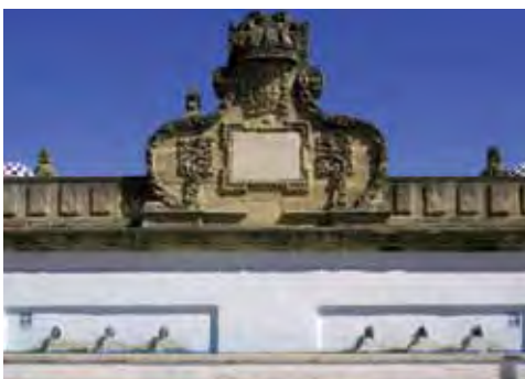
Fuente de las Galeras, El Puerto de Santa María. FOTO: A. CASTILLO.
