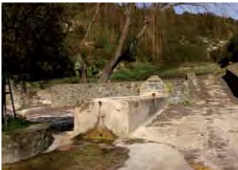
Pilar de las Tenerías, Jerez de la Frontera. Foto: J. M. AMARILLO.
