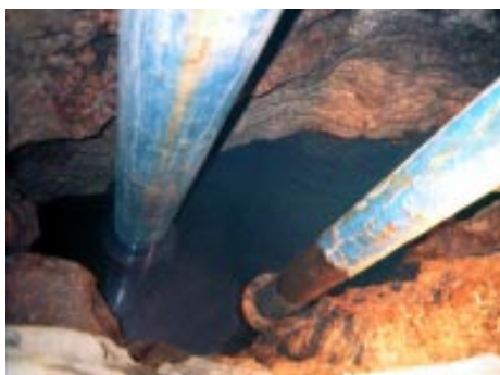
Conducto natural, desde el que se bombea el agua termal ( 32^{\circ}\text{C} ) a las piscinas de los Baños de Sierra Elvira (Foto: A. Castillo Martín)
