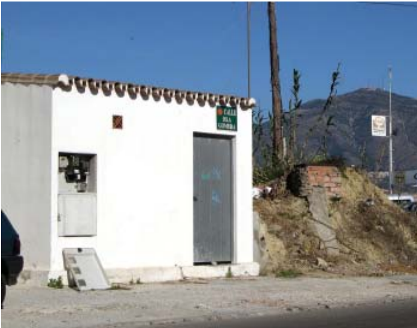
Sondeo profundo en la calle Isla Gomera de Fuengirola
