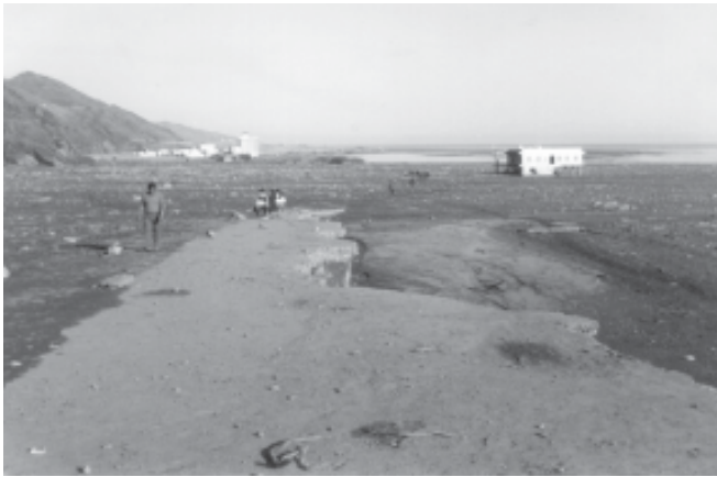
Estado en que quedó la CN-340 a su paso por el delta de Albuñol. Al fondo se observa el hotel mostrado en la foto siguiente (foto cortesía de Angel García Peramos)
