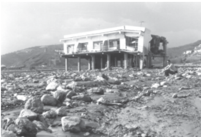
Daños sufridos por uno de los hoteles que había en el delta de Albuñol; otro desapareció con unas 25 personas (foto cortesía de Angel García Peramos)
