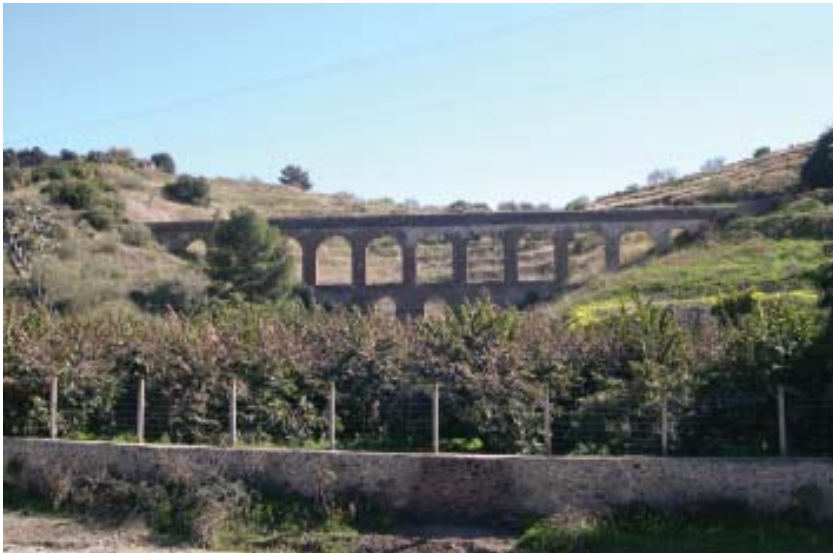
Acueducto romano situado en la margen izquierda del río Seco, por donde discurría el agua trasvasada desde el río Verde, del cual destaca su doble arcada
