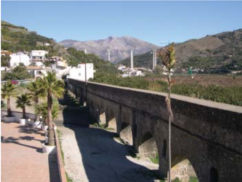
Acueducto de Torrecuevas. Destacan sus arcadas de medio punto, típicamente romanas. Desde aquí se inicia el túnel de trasvase al río Seco
