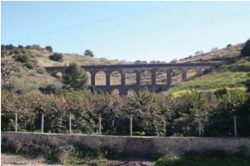
Acueducto romano situado en la margen izquierda del río Seco, por donde discurría el agua trasvasada desde el río Verde, del cual destaca su doble arcada
